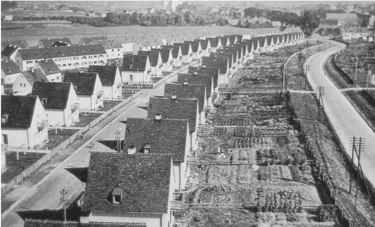
Quartier d'habitation flambant neuf aux abords d'une usine d'aviation à Auxbourg avant la Guerre.
