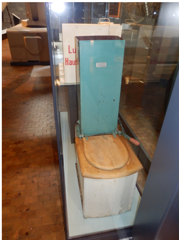
Modèle de toilettes sèches avec réservoir doseur de sciure de bois visible au musée de la technique de Berlin. Ce modèle équipait les abris de protection civile allemands durant la deuxième Guerre Mondiale.
