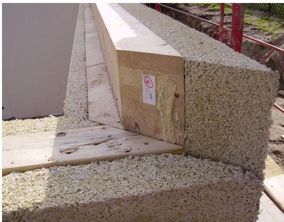
Détail d'assemblage, les murs en béton de chanvre sont préfabriqués puis mis en oeuvre. (prefa Aub.)
