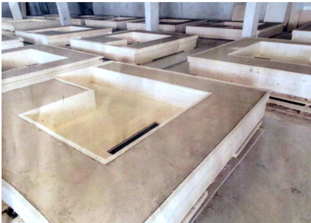
**Enveloppe : de la paille !** Il s'agit, en effet, pour la façade nord, d'éléments préfabriqués ou presque, constitués de paille enserrée dans des cadres en bois. Ces cadres ont été assemblés par les futurs habitants directement sur le chantier dans un espace couvert, le futur garage. Une fois la paille compressée, l'enduit intérieur en terre est simplement lissé à plat, ce qui simplifie considérablement le travail. De même, l'enduit extérieur en terre-sable-
