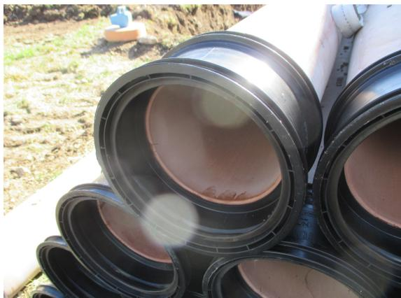
*Les tubes en grès de 2m de long et 15cm de diamètre composant le conduit principal avec à l'extrémité le joint à lèvres*
