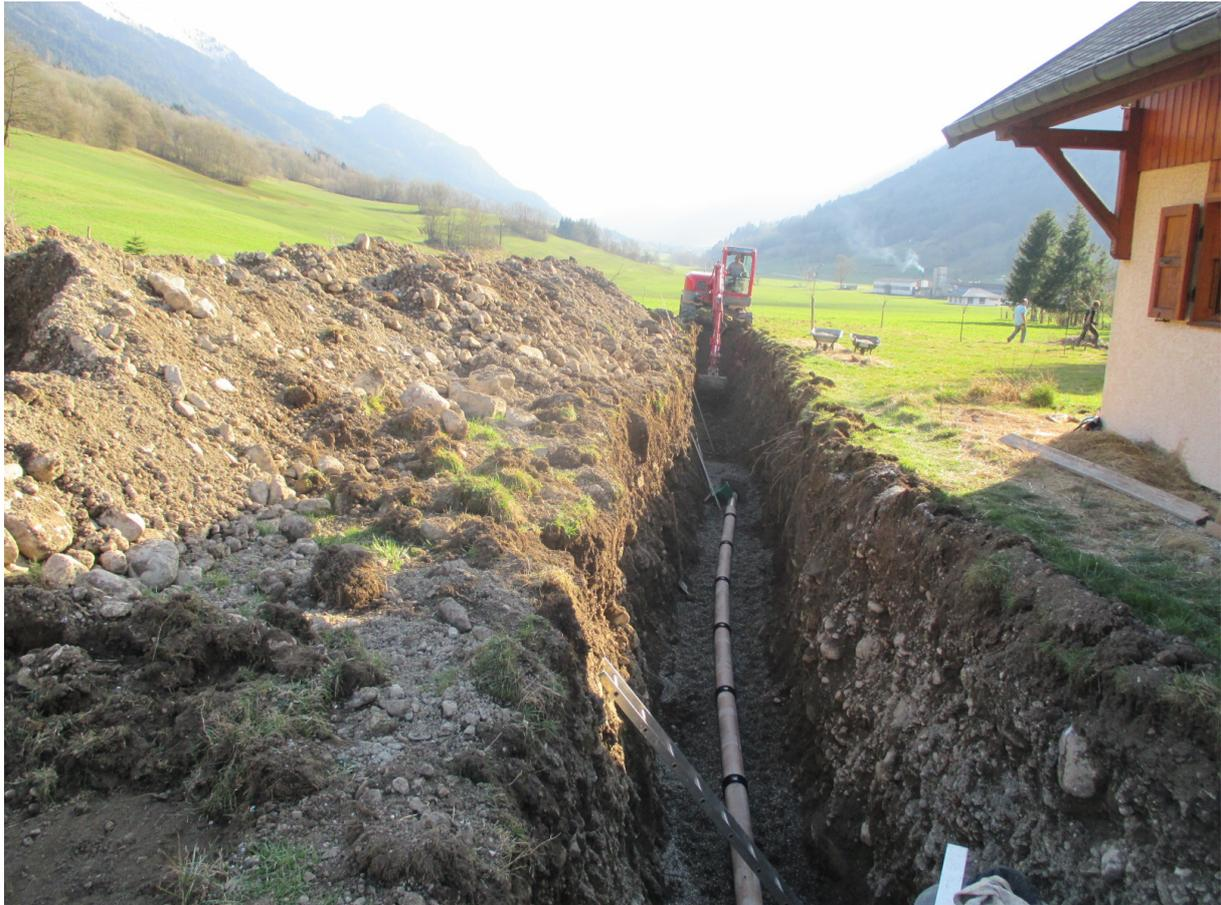
*La fouille de 3m de profondeur avec les tubes posés au fond sur une distance de 30 à 45m*
