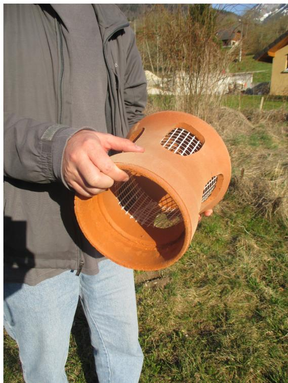
*La prise d'air de l'entrée du puits avec le filtre pour insectes est recouverte de ce chapeau en terre cuite*
