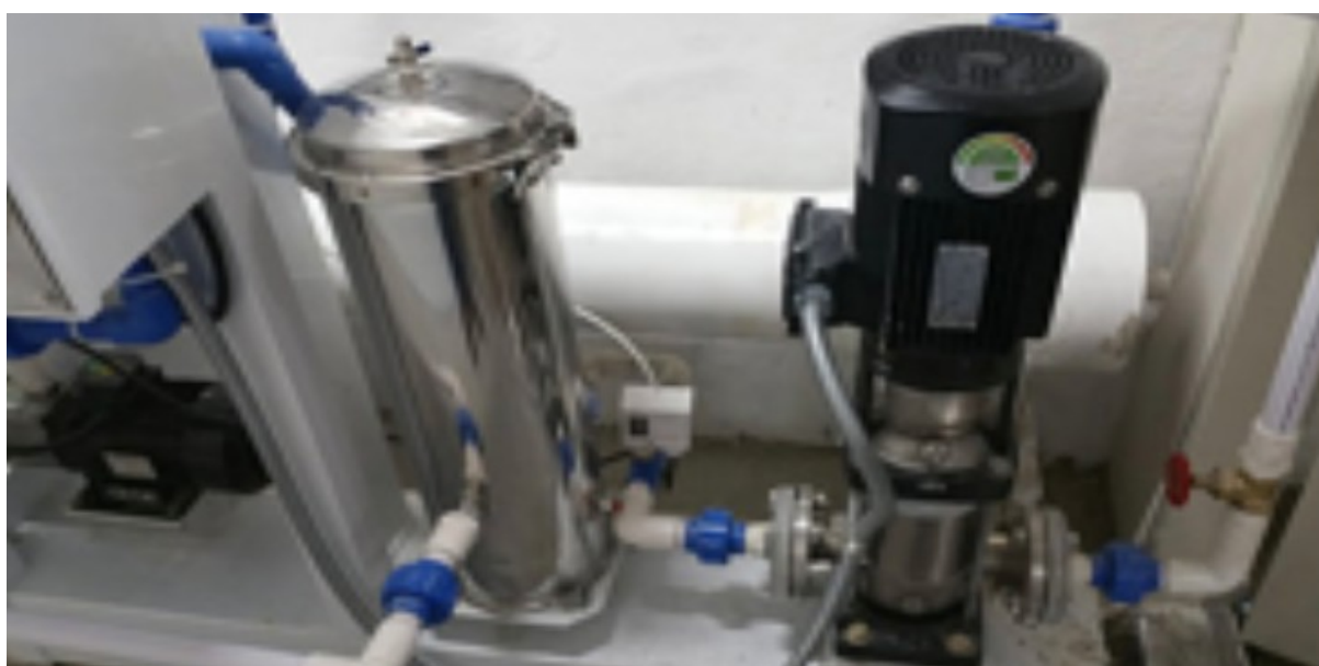
La cuve d'injection d'ozone. (Image via Zerotoilet)
