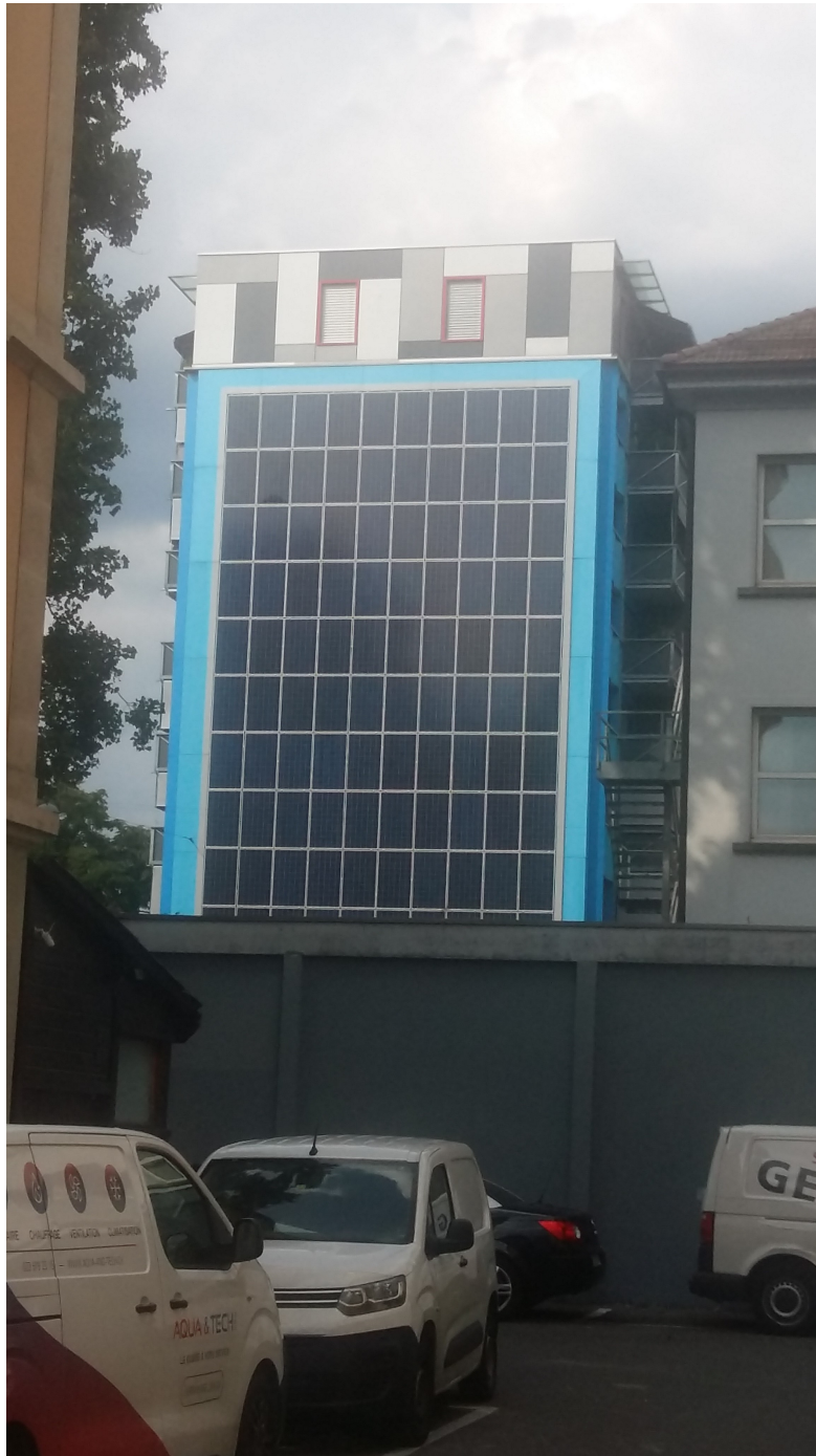
La façade solaire au 9 Chemin des Maraîchers.
